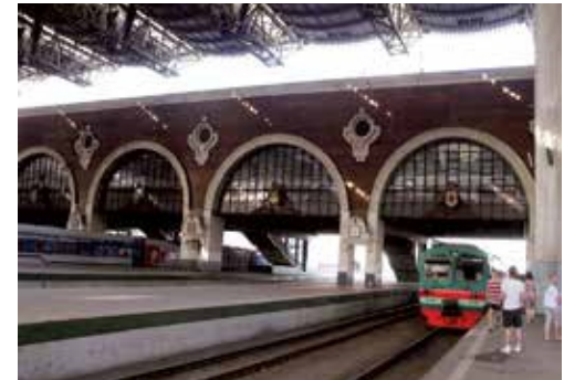
Railway stations Железнодорожные вокзалы
